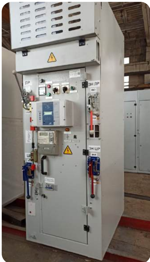
КСО-298 без разделения отсеков
